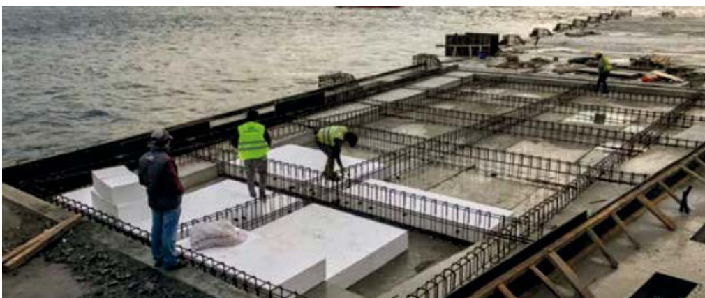
Obrázek 32: Lehká výplň z geofamových bloků pro nájezdovou rampu servisních vozidel (Místo: Kabatas Seagull Project, Kabatas Square and Ferry Transfer Center, Istanbul, Datum: 27.11.2018)
