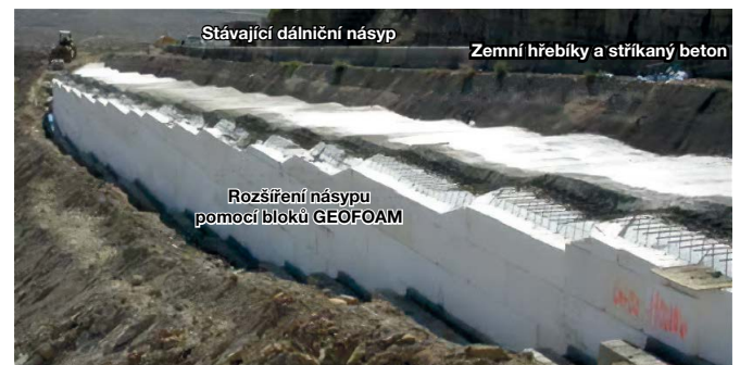
Obrázek 12: Rozšíření násypu se svislou stranou z geofoamových bloků vybudovaného jako výplň bočního svahu přiléhajícího ke stávajícímu násypu vozovky. Uložení geofoamových bloků zahájeno po sanaci svahu zemními hřebíky a torkretováním dokončeném ve stávajícím svahu násypu (Second Mesa/Arizona/USA). (Fotografoval: S. F. Bartlett)
