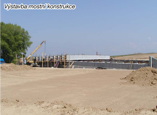
Stupňovitě připravený terén pro pokládku bloků
