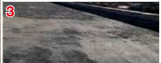
3 Položení železobetonové desky
