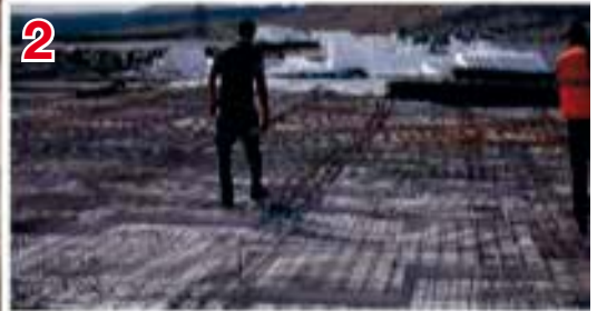
2 Vyztužení železobetonové desky
