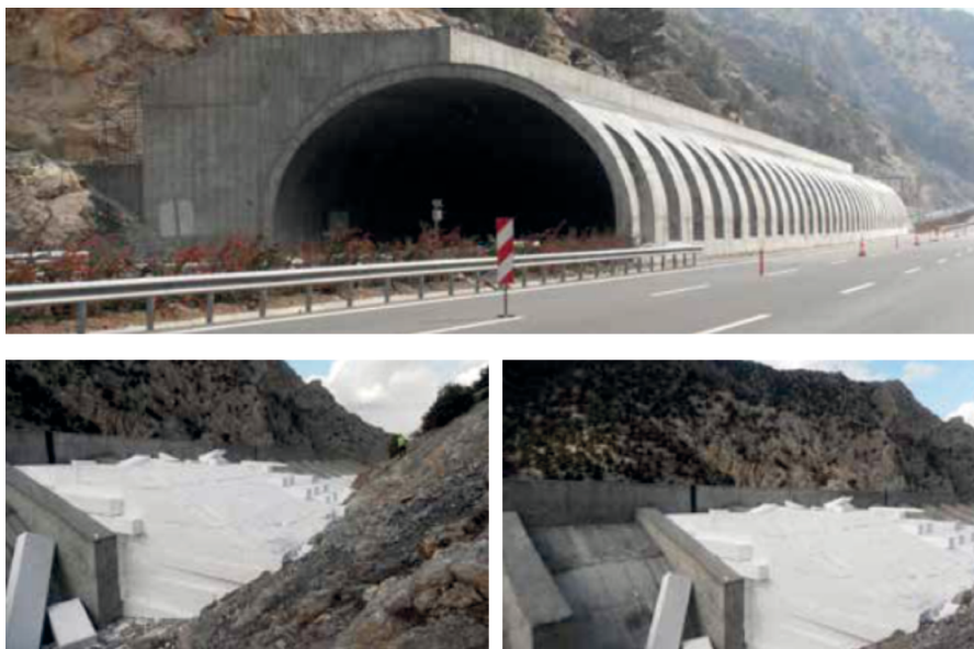
Obrázek 29: Použití bloků GEOFOAM v galeriích pro ochranu proti škodám způsobeným padajícími kameny
