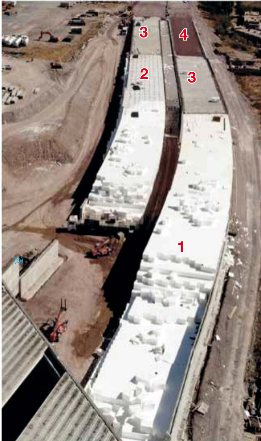
Obrázek 24: Současné provádění stavebních fází geofamových nájezdových násypů mostů (Místo: Bogazkopru-Kocasinan/ Kayseri, Datum: 28.08.2019 -15.10.2019)
