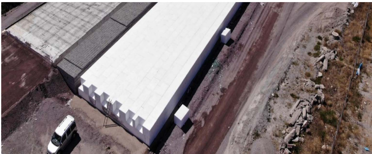
Obrázek 8: Výplň nájezdové rampy
