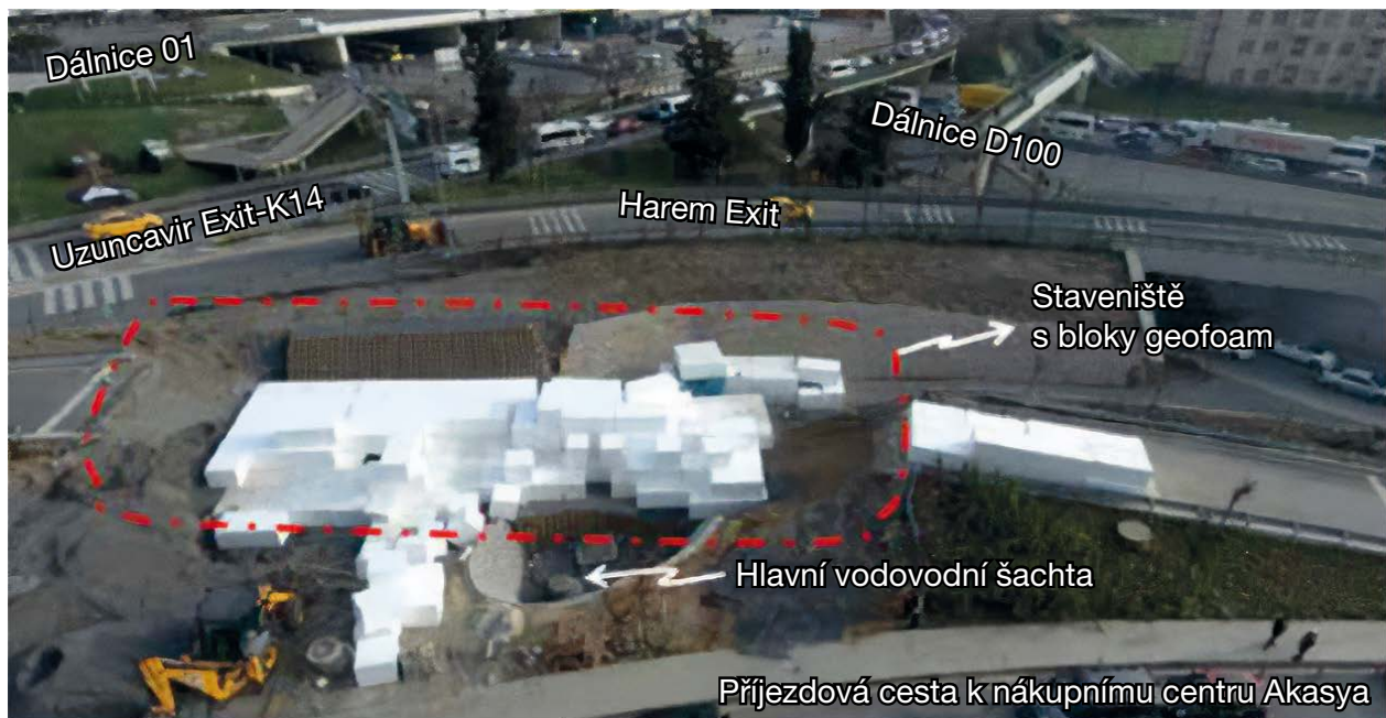
Obrázek 33: První silniční násyp z bloků GEOFOAM v Turecku (Acibadem-Uskudar/Istanbul) (Özer & Akinay, 2017)
