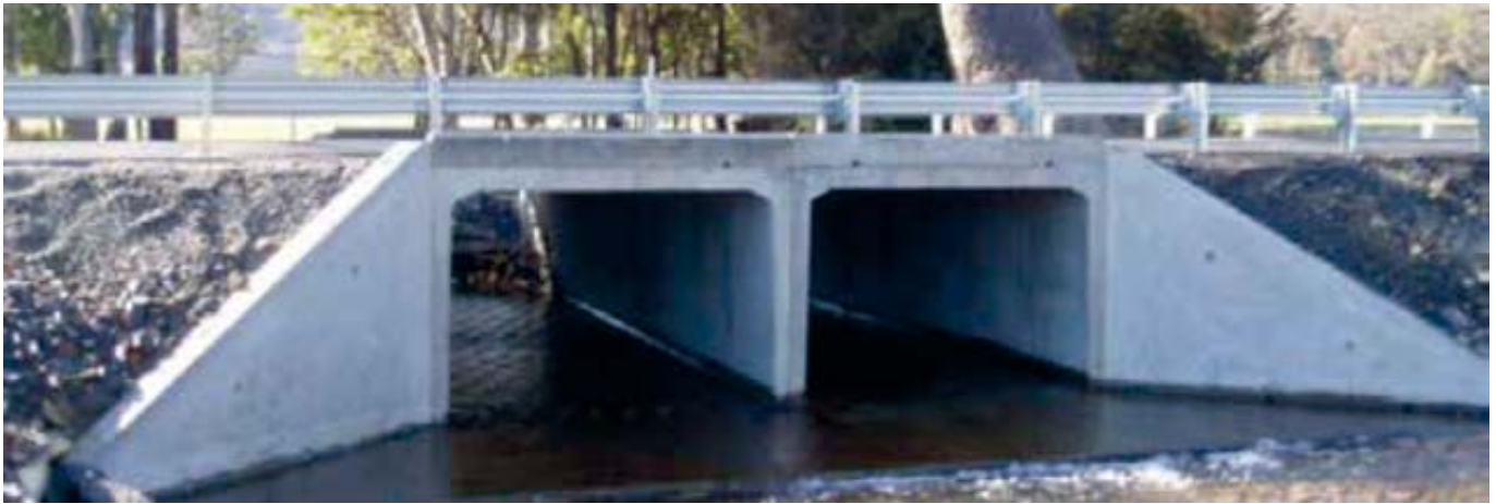
Obrázek 25: Železobetonový propustek s dvojí komorou sloužící jako most (Zdroj: http://www.hudsoncivil.com.au )
