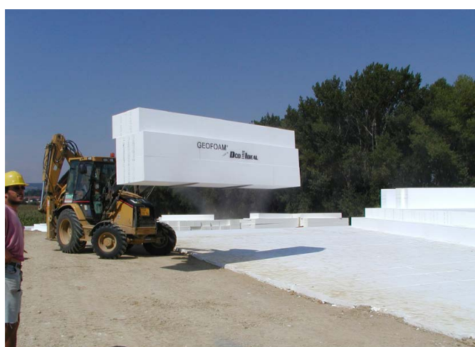
Obrázek 1: Použití bloků GEOFOAM z expandovaného polystyrenu na projekt dálnice D1 – vylehčený násyp u mostního objektu.
