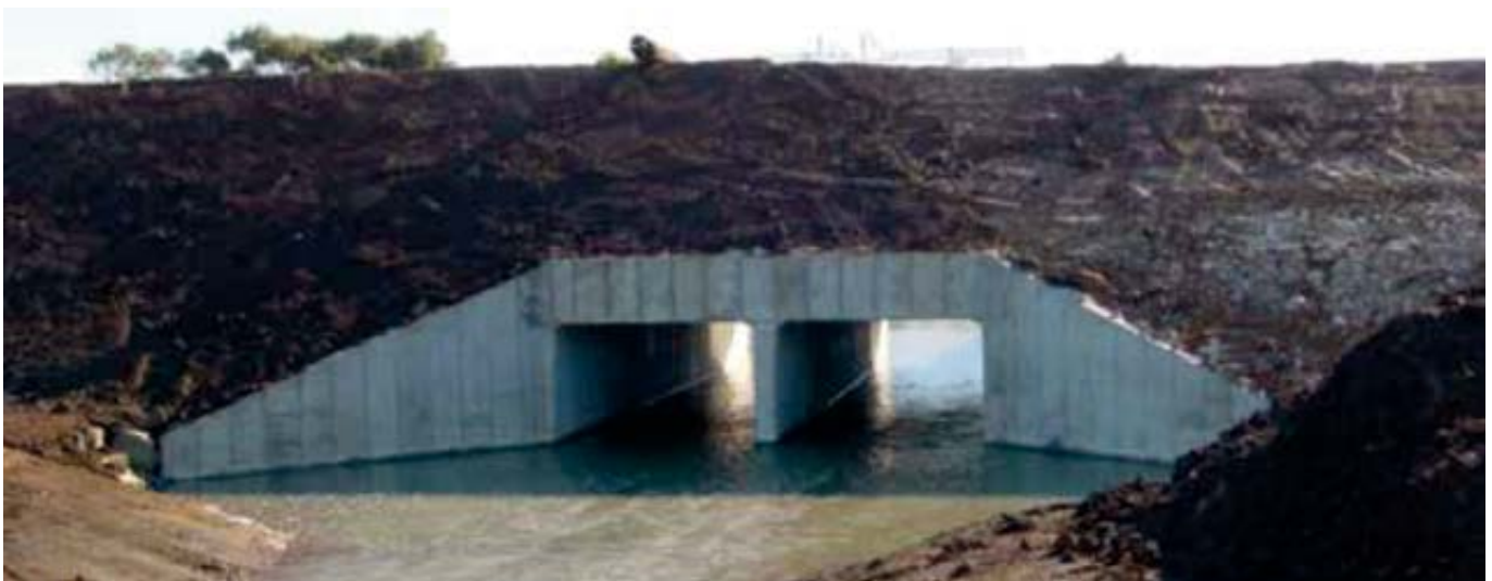
Obrázek 26: Poměrně silný zemní zásyp na vrcholu dvoukomorového železobetonového propustku. (Zdroj: http://www.hudsoncivil.com.au )
