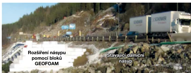
Obrázek 11: Rozšíření násypu pomocí bloků GEOFOAM jako výplně bočního svahu přiléhajícího ke stabilnímu svahu stávajícího násypu (Vinterbro/Ås/Akershus/Norveč), (Damtevd., 2011)
