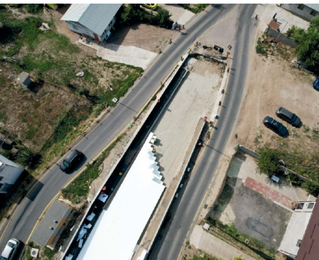
Obrázek 37: Výstavba prvního násypu z bloků GEOFOAM v Rumunsku
