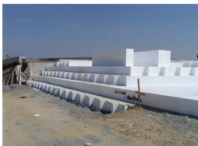
Obrázek 1: Použití bloků GEOFOAM z expandovaného polystyrenu na projekt dálnice D1 – vylehčený násyp u mostního objektu.
