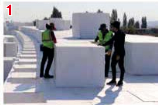
1 Položení bloků GEOFOAM
