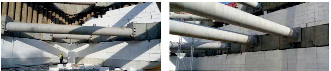
Obrázek 30: Použití bloků GEOFOAM v projektu hlubokého výkopu (Místo: Atakoy-Ikitelli Subway Bahariye Station, Bahariye-Ikitelli/Kucukcekmece, Istanbul, Datum: 22.10.2018)
