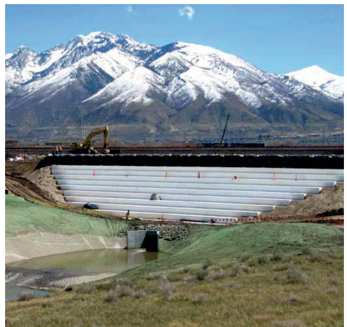
Obrázek 28: Aplikace, kde je výplň z geofomových bloků postavena na vrcholu jednodemového železobetonového propustku: Rozšíření železničního násypu bylo provedeno pomocí geofomových bloků, aby se zabránilo dílčímu sedání, které by mohlo způsobit poškození konstrukce propustku. (Draper/Utah/A.B.D.), (Bartlett et al., 2015)
