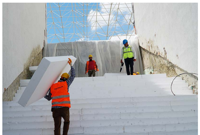
Obrázek 39: Konstrukce schodů s materiálem GEOFOAM odlehčuje zatížení
