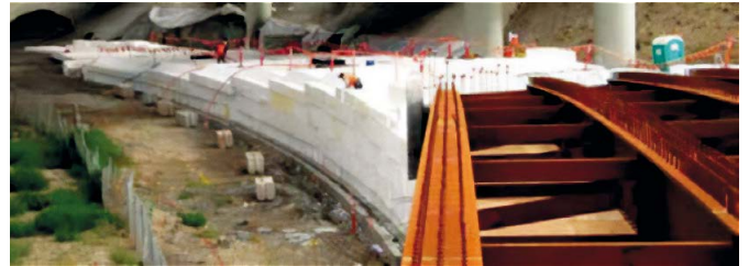
Obrázek 19: Nájezdový násyp mostu z bloků GEOFOAM: Dálnice I-15 (Salt Lake City/Utah/USA) (Fotografoval: S. F. Bartlett)
