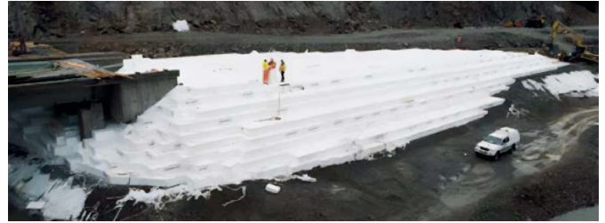
Obrázek 18: Nájezdový násyp mostu z bloků GEOFOAM (Norsko), (EUMEPS, 2010)
