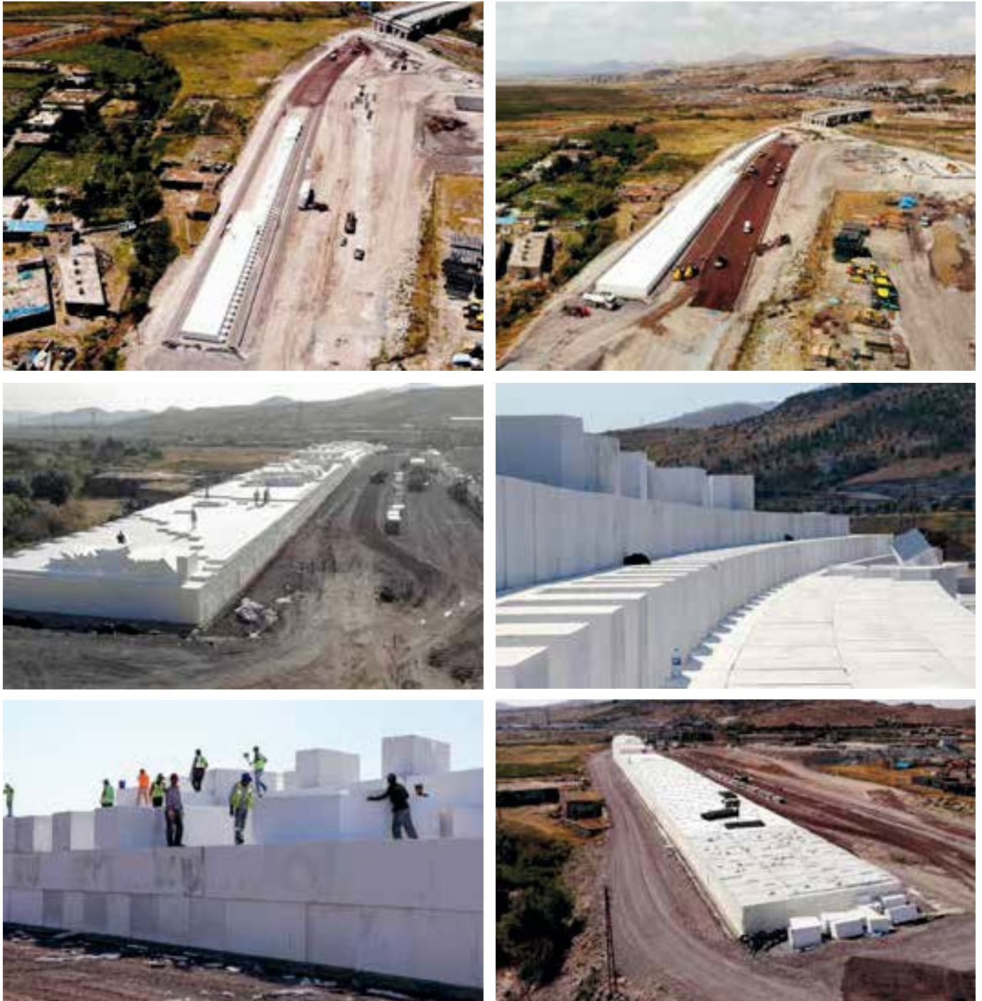
Obrázek 21: Fáze výstavby geofoamových nájezdových násypů mostů – letecké snímky: (Místo: Bogazkopru-Kocasinan/Kayseri, Datum:08.08.2019 -19.11.2019)
