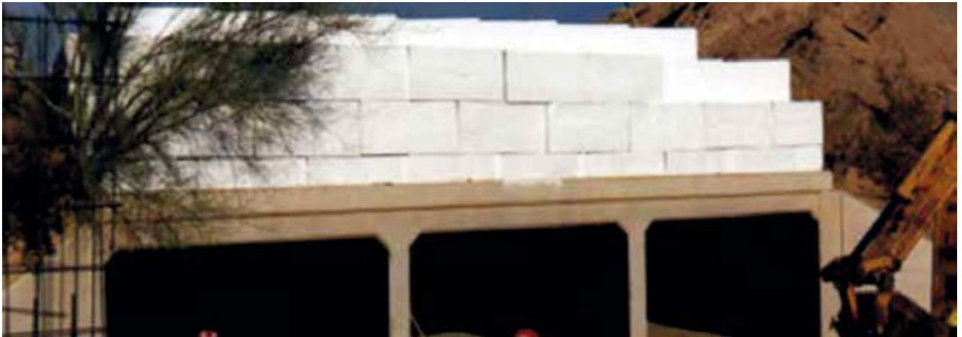
Obrázek 27: Výplň z geofomových bloků na vrcholu tříkomorového železobetonového propustku: Konstrukce výplně násypu na propustku pomocí technologie GEOFOAM výrazně snížila zatížení propustku. (Alton/Iowa/U.S.A.) (Zdroj: https://www.achfoam.com/ )
