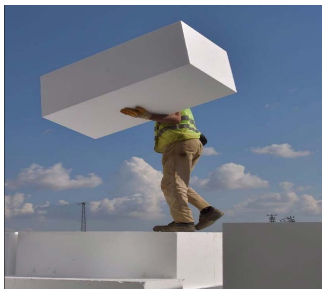
Obrázek 3: Snadná manipulace s materiálem Austrotherm EPS GEOFOAM®
