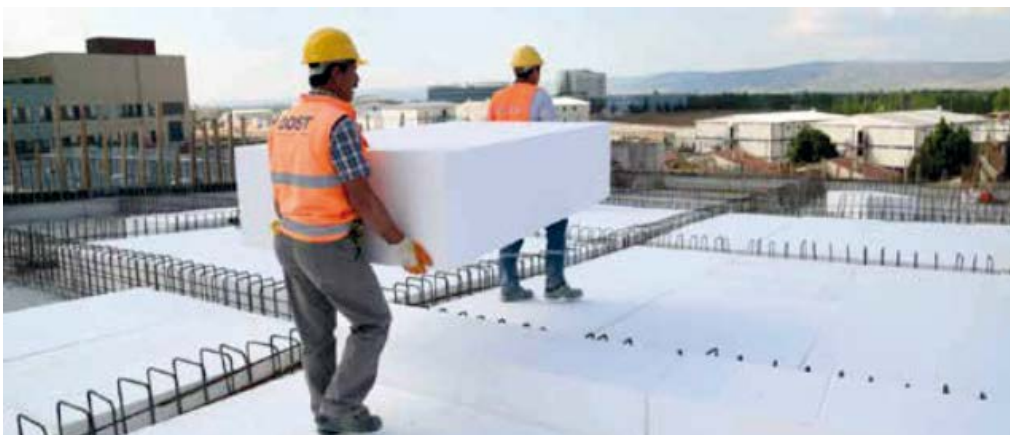
Obrázek 31: Lehká výplň z bloků GEOFOAM pro nájezdovou rampu záchranné služby (Místo: Městská nemocnice Eskişehir, Odunpazari/Eskişehir, Datum: 03.05.2018)
