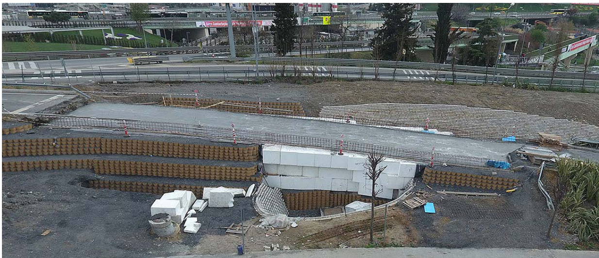
Obrázek 7: Výstavba silničního násypu
